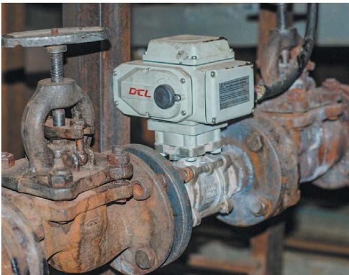
Электропривод KIPVALVE DCL управляет подачей пара в системе нагрева воды (бойлере). Установлен в 2011 году.
