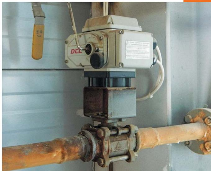
Электропривод KIPVALVE DCL управляет подачей пара при «пропаривании» круп. Установлен в 2013 году.
