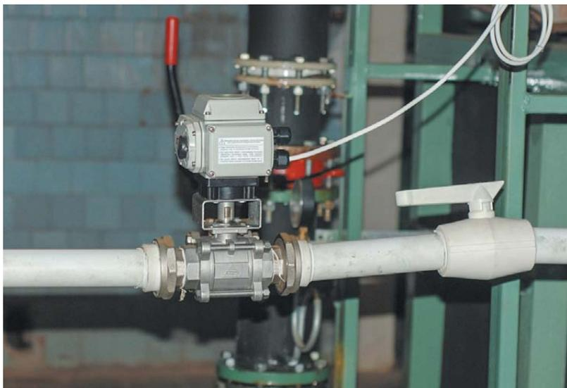
Электропривод KIPVALVE DCL в системе управления подачей холодной воды в контур охлаждения пастеризатора. Установлен в 2012 году.
